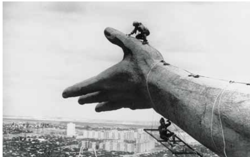
134 Reparaturarbeiten an der Statue der »Mutter Heimat«, Wolgograd o.D.
