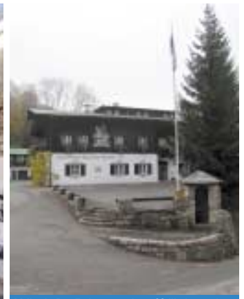
11 Hotel „Zum Türken“ mit ehem. SS-Wachpostenhaus
